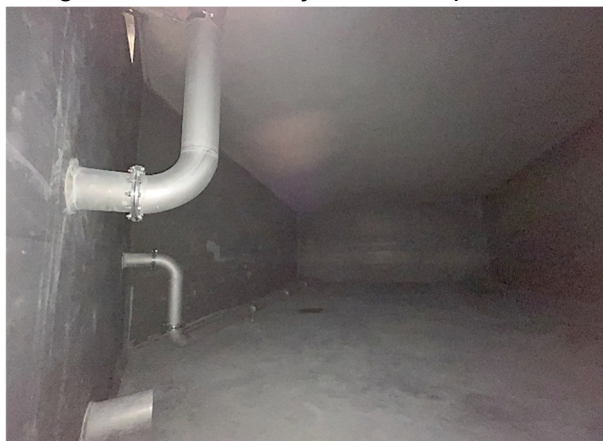
Saugbehälterkammer, je 500 m 3 Sp.volumen
