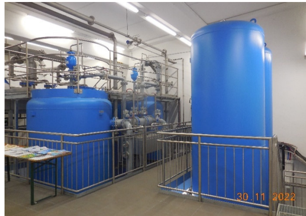
Förderpumpwerk und Druckstoßbehälter
