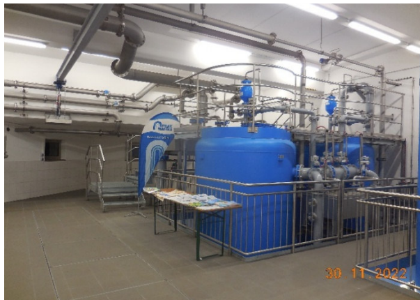
Saugbehälterkammer, je 500 m 3 Sp.volumen
