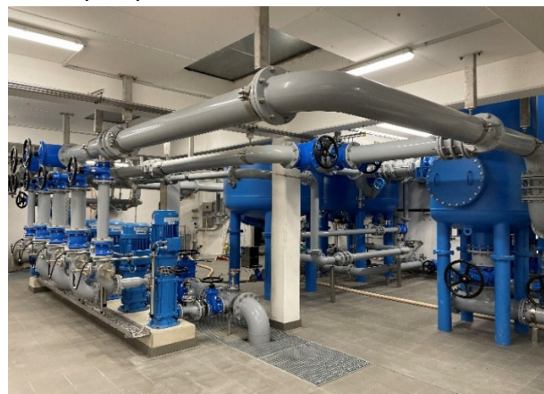
Förderpumpwerk und Druckstoßbehälter
